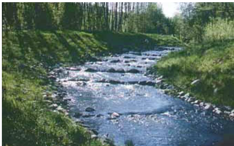
Figura 5.3.12 - Esempio di un canale by-pass per l'ittiofauna realizzato.
